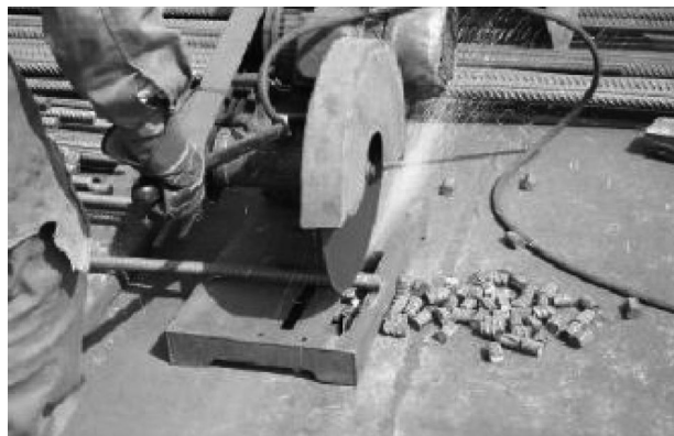
图3 钢筋切断
