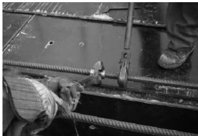
图 5 剥肋直螺纹接头的连接
