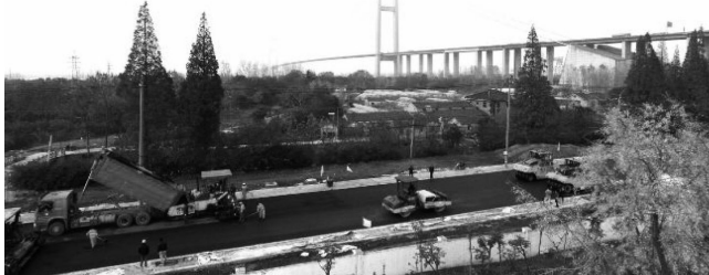
图2 施工现场压路机施工作业
