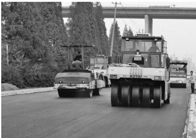
图1 施工现场压路机施工作业
