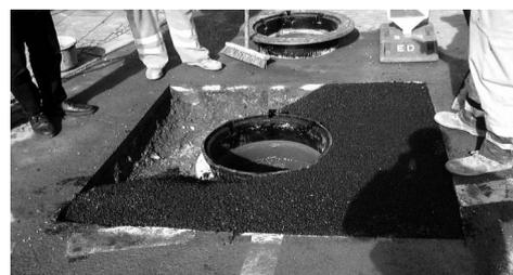
图14 分层填筑沥青混合料
