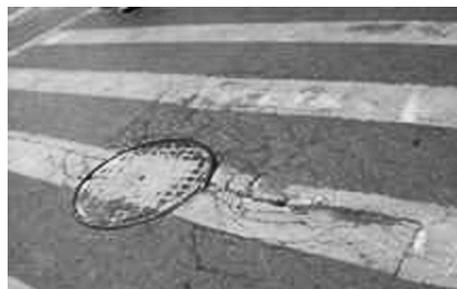
图2 井圈周围路面凹陷开裂
