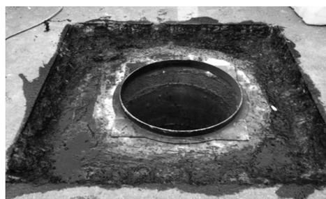
图11 铸铁调节环安装
