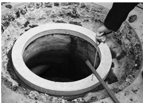
图10 预制砼调节环安装
