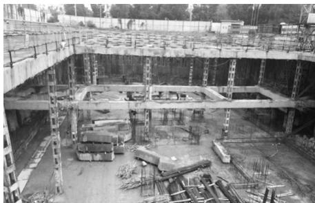
图8 第二道支撑拆除施工
