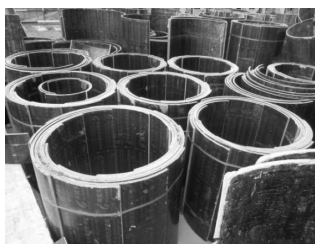
图2 木制定型圆模板堆放
