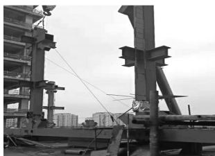
图5 立柱吊装
