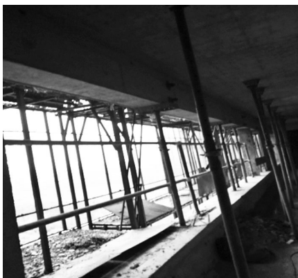
图 8 连廊爬架支承处下方支撑图
