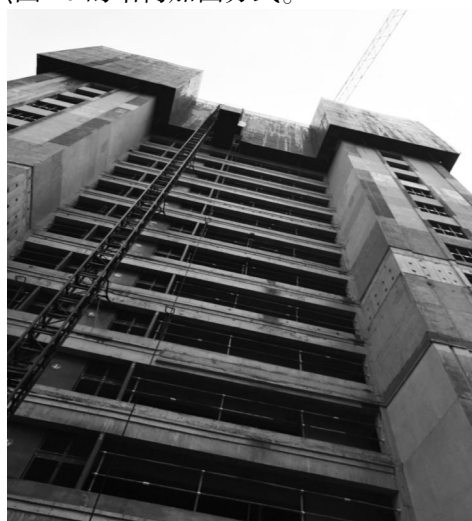
图7 连廊爬架现场实体图片
