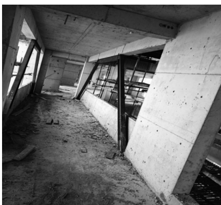
图 10 连廊脚手架下方工字钢加固图
