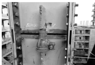
图6 立柱焊接
