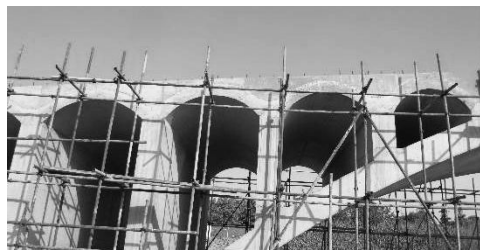
图 9 砼圆弧及桥拱成型效果图
