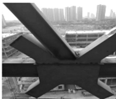
图9 焊接成形的楼层板支座
