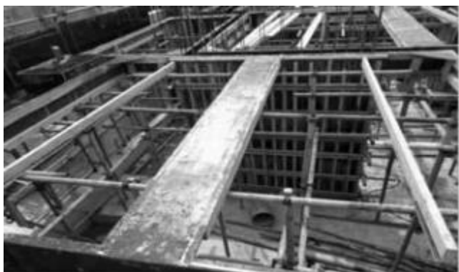
图7 叠合板现浇板带构造
