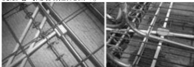
图6 现浇层电气配管的排列
