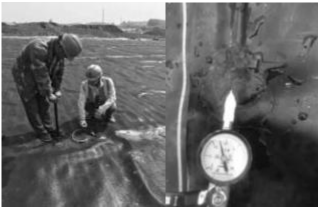
图 2 现场气压检测试验
