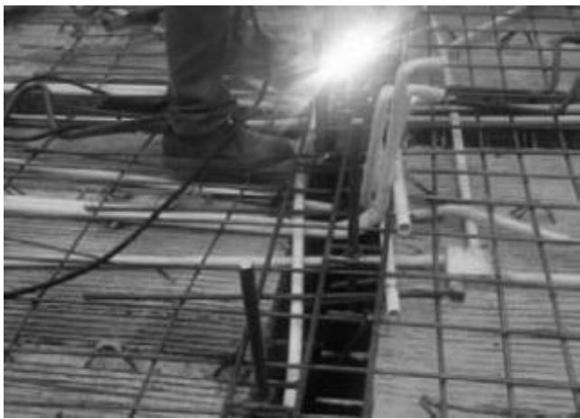
图 4 定位钢筋网格焊接
