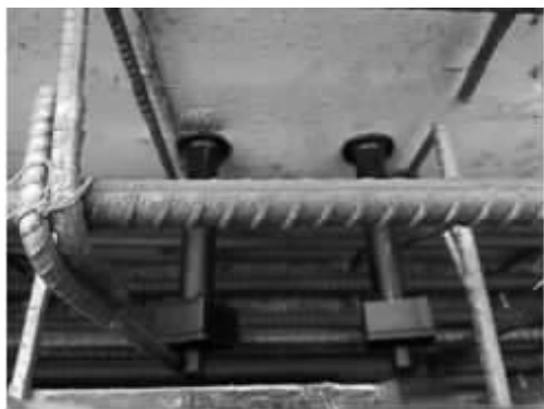
图4 固定悬挑梁端部螺栓预埋实景图
