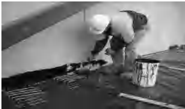
图 8 墙板界面刷隔离剂
