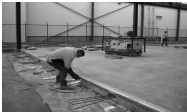
图19 切割钢绞线
