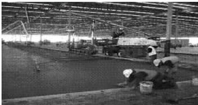
图 15 除泌水施工
