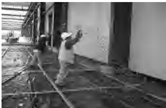
图 13 构造钢筋的安装
