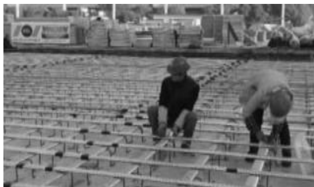
图 12 波纹管布设
