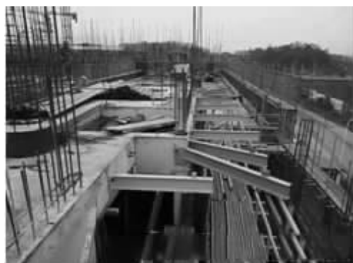
图5 悬挑梁安装实景图
