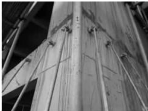
图 3 上拉杆安装实图
